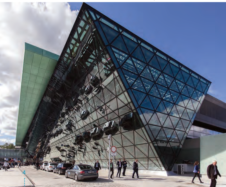
Aeropuerto de Cracovia-Balice
